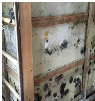
急いで壁紙だけ貼り替えると、後からカビが出て工事をやり直す例もあるので、壁の内側がどうなっているか確認した方が無難です。壁の内側に断熱材が入っている場合は天井近くまで水が上がる場合もあります。
