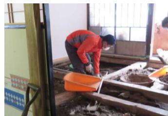
ある家の改修で、最初は壁紙を張り替える予定が、カビの匂いがしたので剥がしてみると、一面カビだらけでした。そこで全ての壁を剥がしエタノールでカビを落とし壁を貼り直しました。
